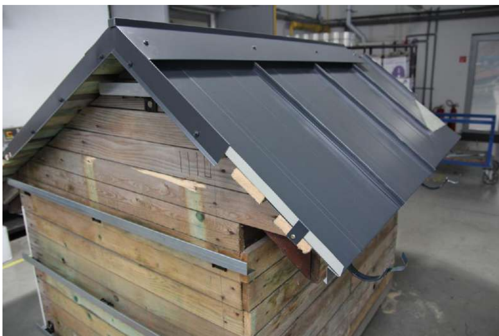
Obr. 7 Okrajové a ukončovacie lemovania pri falcovanej strešnej krytine
