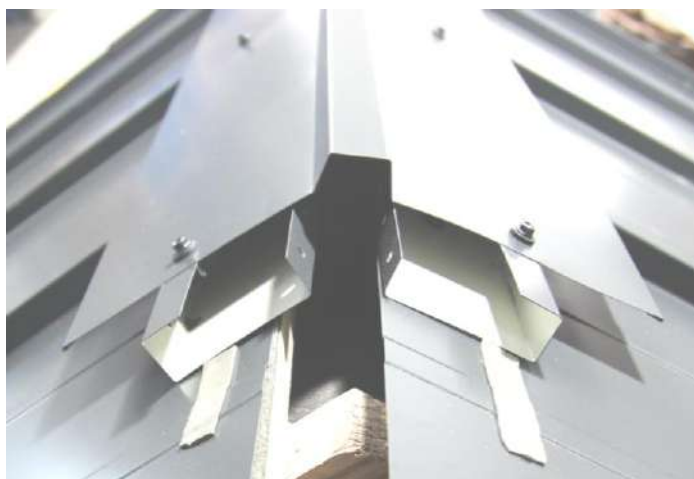
Obr. 8 Odvetranie hrebeňa- pod vetrací profil použité tesniace pásky Butyl Band
