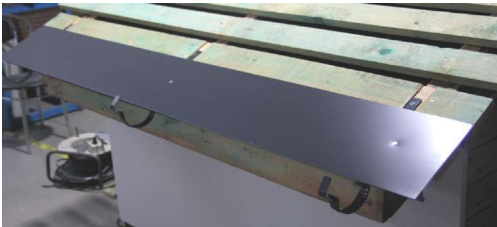
Obr. 4 Odkvapové lemovanie
