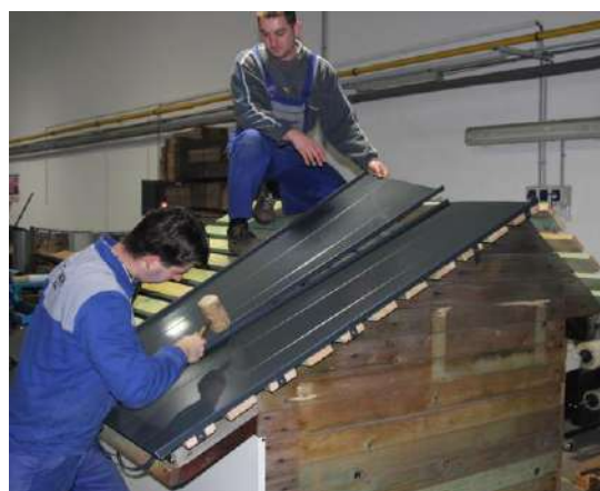
Obr. 6 Uloženie strešnej krytiny CLIP PANEL
