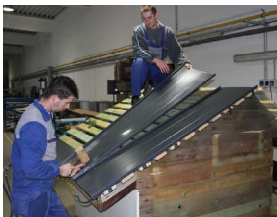
Obr. 6 Uloženie strešnej krytiny CLIP PANEL
