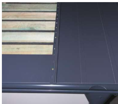
Obr. 5 Úprava strešnej krytiny CLIP PANEL- predpríprava k odkvapovému lemovaniu
