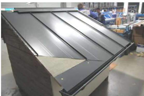
Obr. 7 Strešný difúzne uzavretý asfaltový poistný pás Bauder TOP TS 40 NSK so samolepiacim pozdĺžnym spojom
