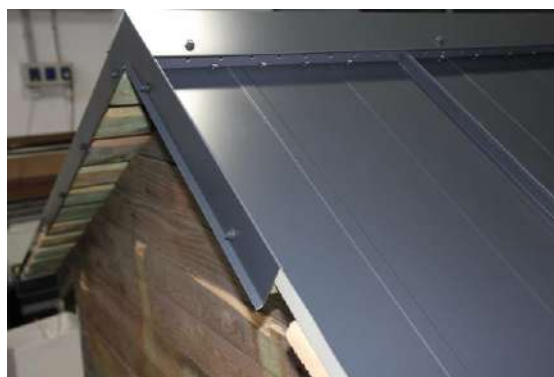
Obr. 9 Okrajové a ukončovacie lišty pri strešnej krytine CLIP PANEL
